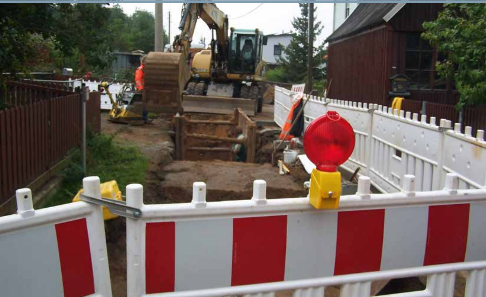
Straßen- und Leitungsarbeiten in Wilsdruff
